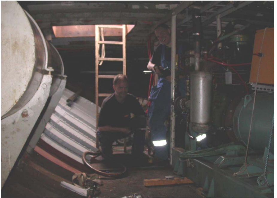
2004 kom Magnus Fyrberg in i bilden. Här hjälper han Carl Axel sommaren 2006 att flytta dieselgeneratorn på plats och fixera den på vibrationsdämpande kuddar. Kylaren till Bolindern gjordes av en av Carl Axels gamla dykartuber.
