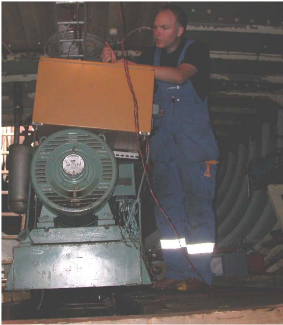
2004 kom Magnus Fyrberg in i bilden. Här hjälper han Carl Axel sommaren 2006 att flytta dieselgeneratorn på plats och fixera den på vibrationsdämpande kuddar. Kylaren till Bolindern gjordes av en av Carl Axels gamla dykartuber.
